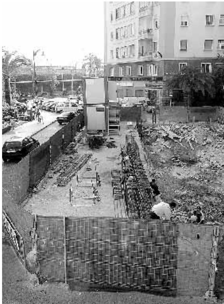
CONSTRUCCIÓN. Aspecto que muestran las obras. / C. MORET
